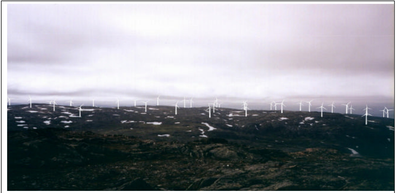
Bilde 7-5 Kvifjell vindpark sett fra Raudfjellet.
