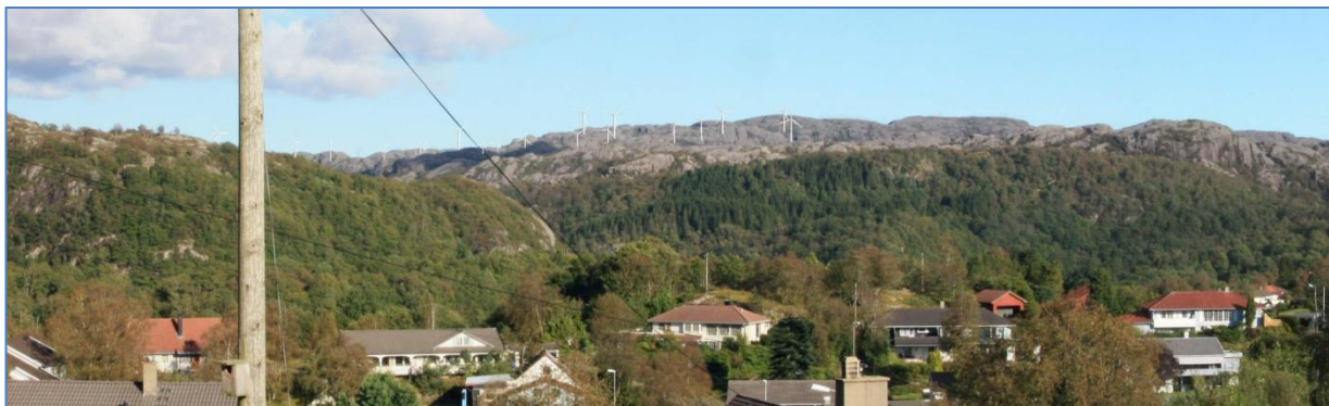
Figur 5-9. Tellenes vindkraftverk sett fra Sokndal. Utsnitt av visualisering. Ill.: Sweco.
