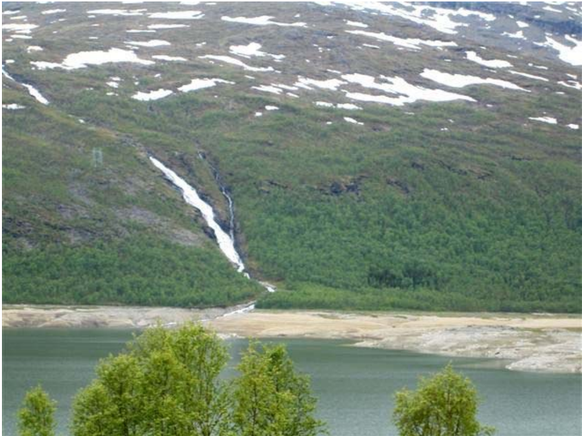
Bilde 4.1 Kraftstasjonsområde midt i bildet ned mot Storvatnet
