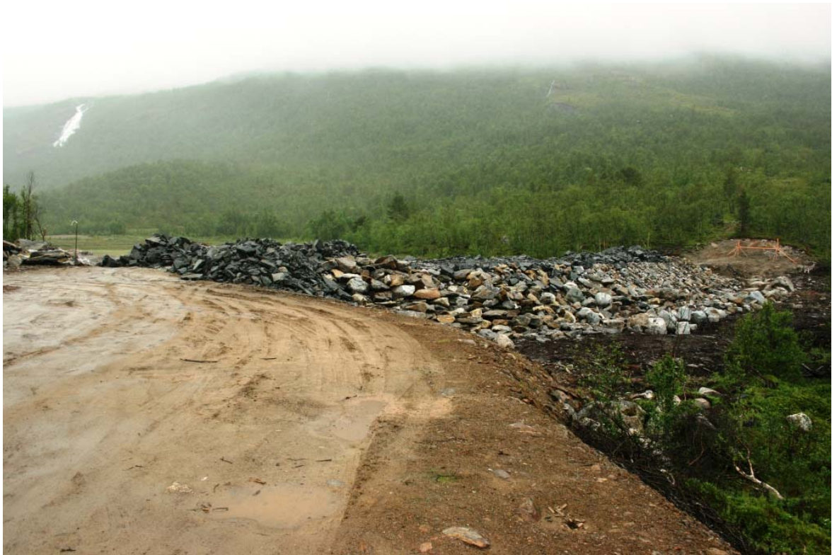
Bilde 6.3 Rehabilitering av sperredam
