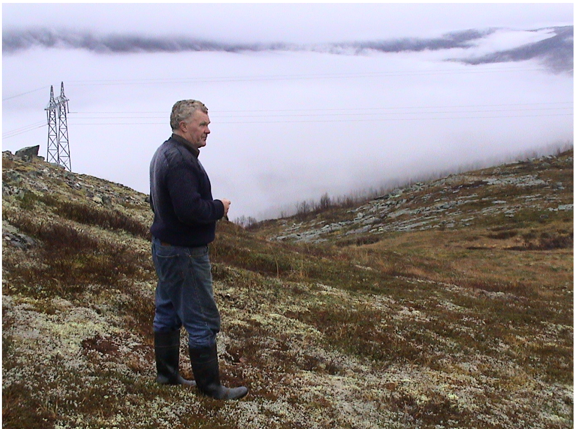
Bilde 3.2 Rørgatetrase nedover fra toppen med kraftlinje
