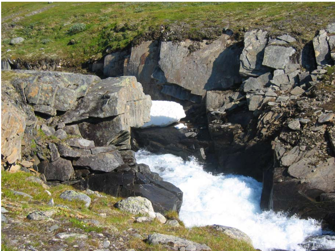
Bilde 1.2 Nedstrøms inntaket den 19. juli 2005 - Q = 1,9 \text{ m}^3/\text{sek}
