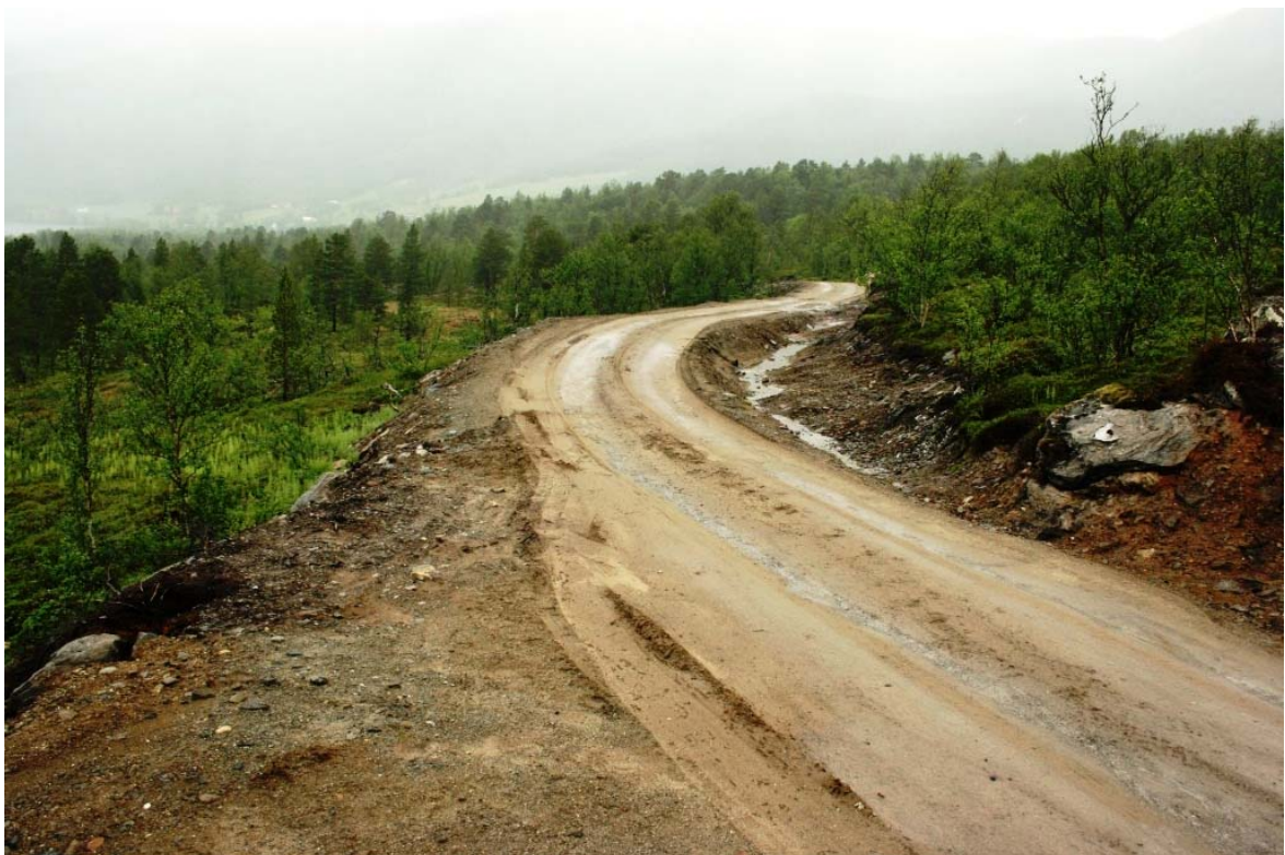
Bilde 1.2 Adkomstvei til sperredam
