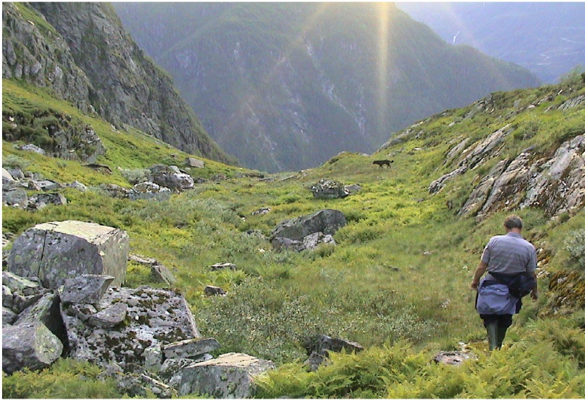
Planlagt rørgate ved kote 700. Tverrelvas løp bak fjellryggen t.h.
