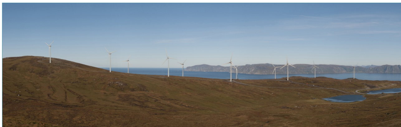
Figur 5-3 Mehuken 3 vindkraftverk sett fra Kvalheimshornet. På dette bildet er den gamle ledningen til Kråkenes vist sanert. Foto og fotomontasje: Einar Berg, Norconsult.
