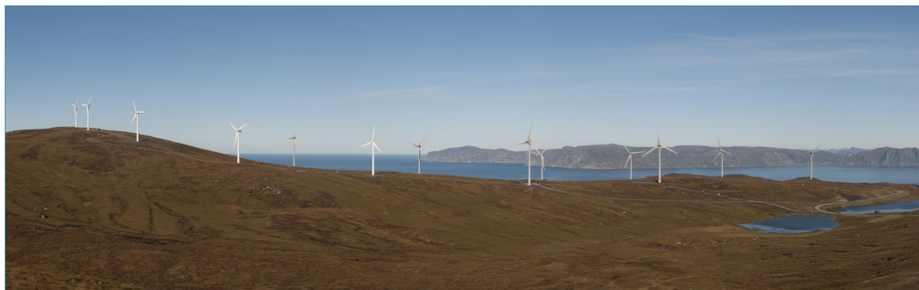
Figur 5-2 Mehuken vindkraftverk sett fra Kvalheimshornet, dagens situasjon. Det har skjedd en endring siden bildet ble tatt i 2010: den gamle ledningen fra Kvalheim til Kråkenes som er synlig i dette bildet gikk gjennom naturreservatet er nå revet. Foto: Einar Berg, Norconsult.
