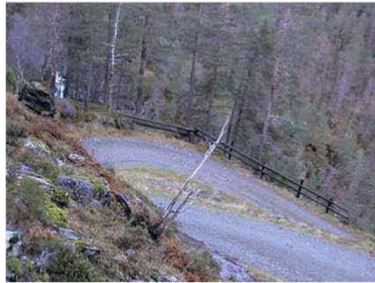
Bilde 3.2 Der røret kommer frem til veien
