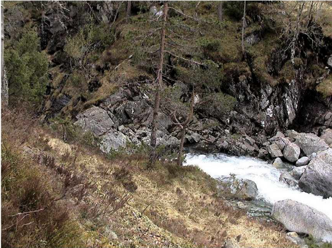
Bilde 2.3 Damkrone – på kote 340 moh
