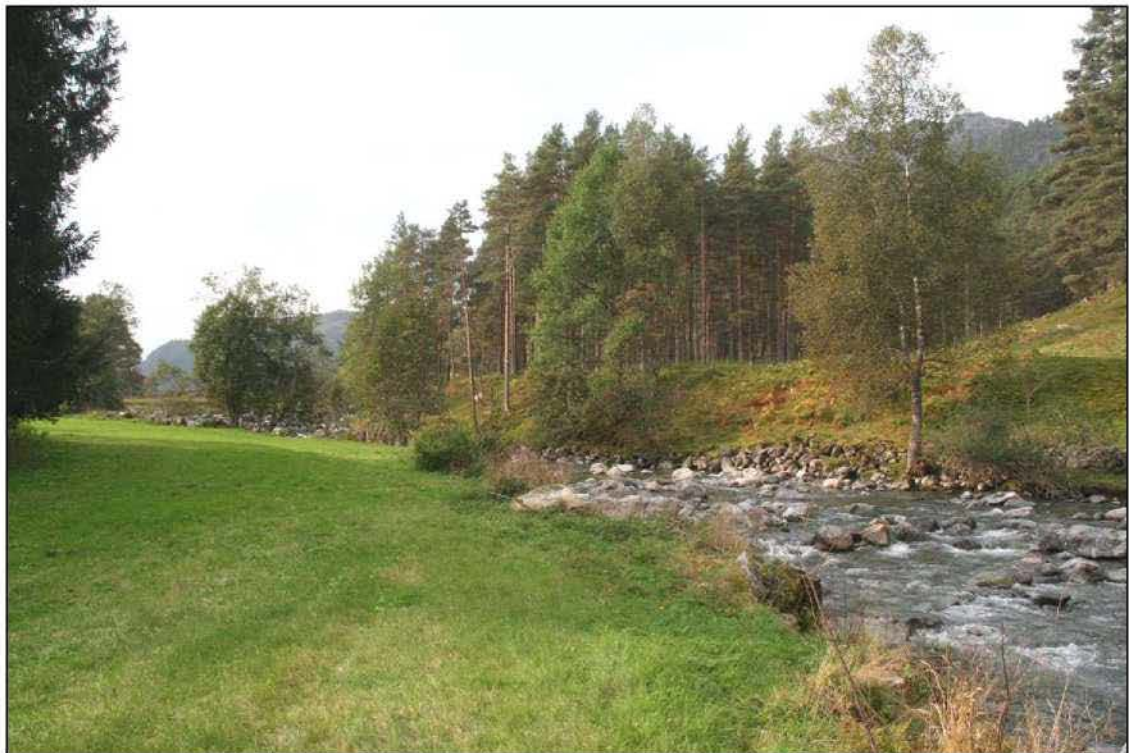
Figur 4. Område for planlagt kraftstasjon ved Eikemoelva, ca. kote 190, fotografert mot vestsørvest 26. september 2006. Hovedutbyggingsalternativet vil medføre at kraftstasjonen blir plassert på nordsiden av elva (til høyre). Ved alternativ vest legges rørgata/kraftstasjonen på flaten sør for elva (til venstre) (foto: Ole Kristian Spikkeland).
