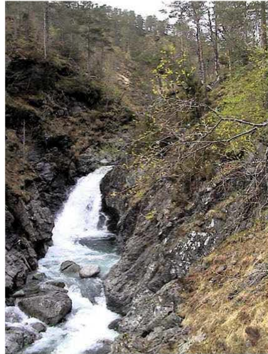
Bilde 1.2 Opp mot demning
