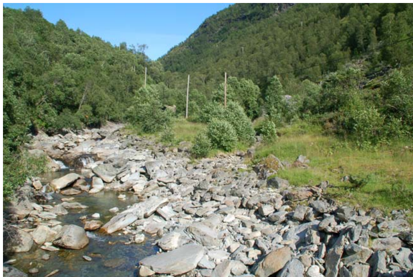
Området ved inntaket til det nedre kraftverket og kraftstasjonen til det øvre kraftverket
