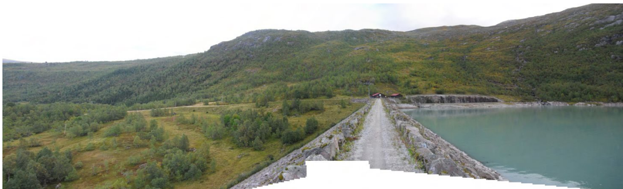
Foto 3: Tunsbergdalsvatn sett mot fjellsiden sør for dammen hvor det kan gå skred.
