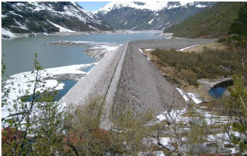
Figur 3.6. Oversiktbilder dam med utløp av flomkanal til høyre
