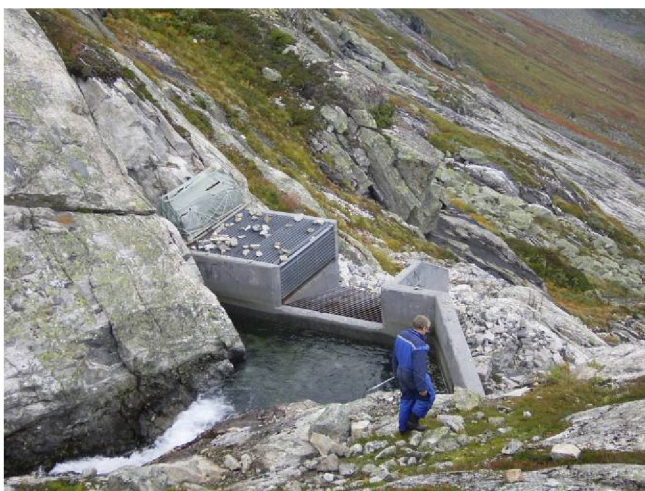
Figur 3.5. Vivaskredene bekkeinntak. De planlagte bekkeinntakene blir av lignende type som dette.
