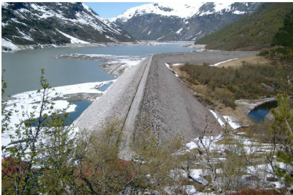
Figur 3.6. Oversiktsbilde dam med utløp av flomkanal til høyre
