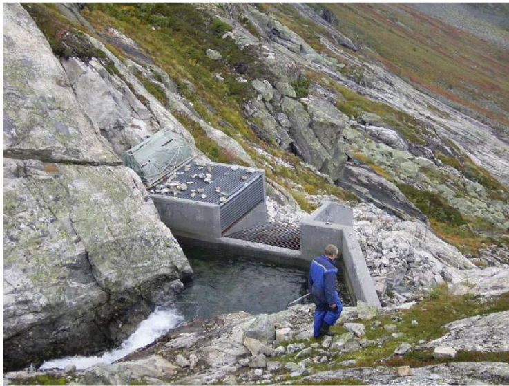
Figur 5 Vivaskredene bekkeinntak. De planlagte bekkeinntakene blir av lignende type som dette.
