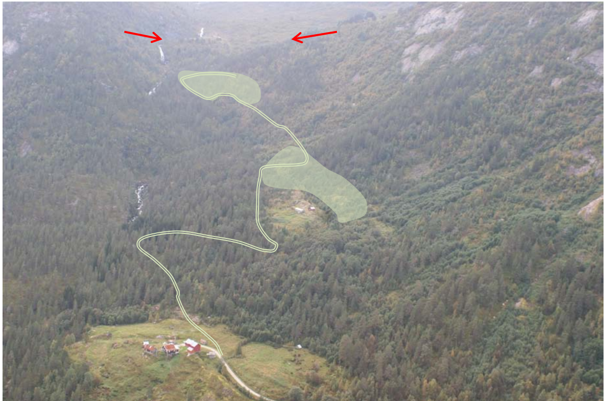
Figur 161 Sperleelvi nederst og Vassdøla og Liadøla (ikke synlig). Inntakspunkter (røde piler), omtrentlig plassering av planlagt tipper (grønne områder) og trasé for planlagt anleggsvei er inntegnet. Gårdshaug foran og Gardsvårstølen bak.
