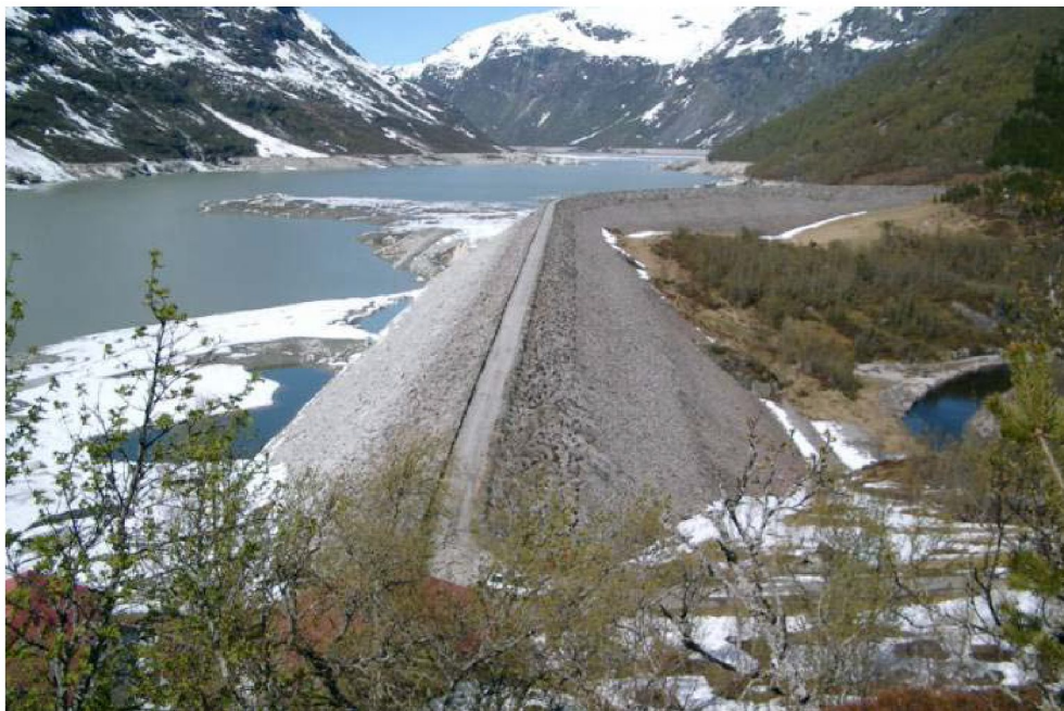
Figur 3.6. Oversiktbilder dam med utløp av flomkanal til høyre
