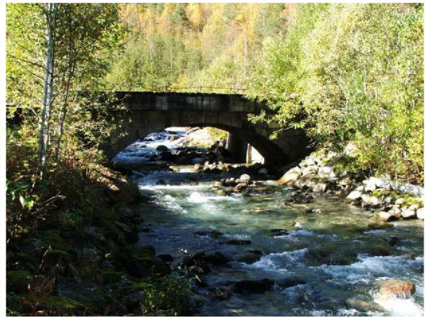
Fig. 5.12. Sperle Bru fra 1912, ved riksvegen på Sperle.
