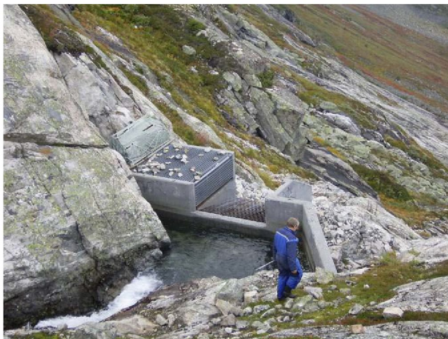
Figur 3.5. Vivaskredene bekkeinntak. De planlagte bekkeinntakene blir av lignende type som dette.
