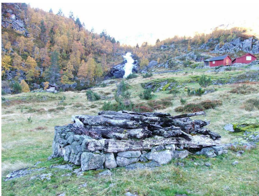
Fig. 5.8. Fra stovsvollen på Sperlestølen, deler av eksisterende bygningsmasse oppe til høyre. Bildet illustrerer stølens nærhet til og kontakt med Vassdøla, med fossefallet overfor inntakspunktet i bakgrunnen.
