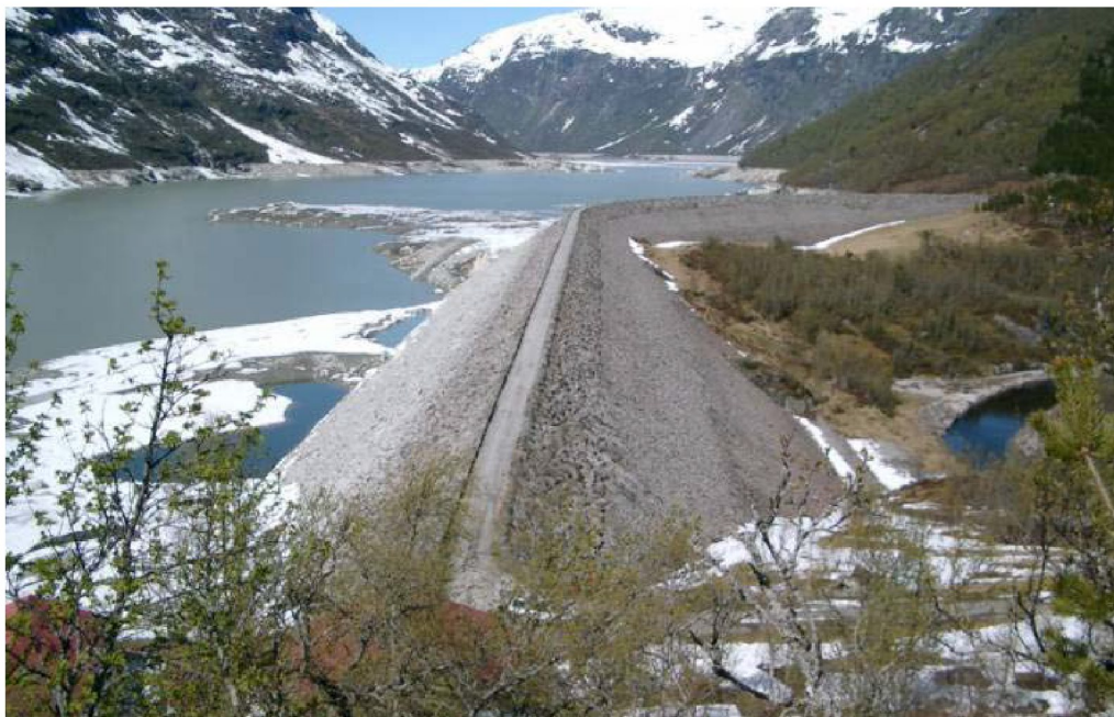
Figur 3.6. Oversiktsbilder dam med utløp av flomkanal til høyre
