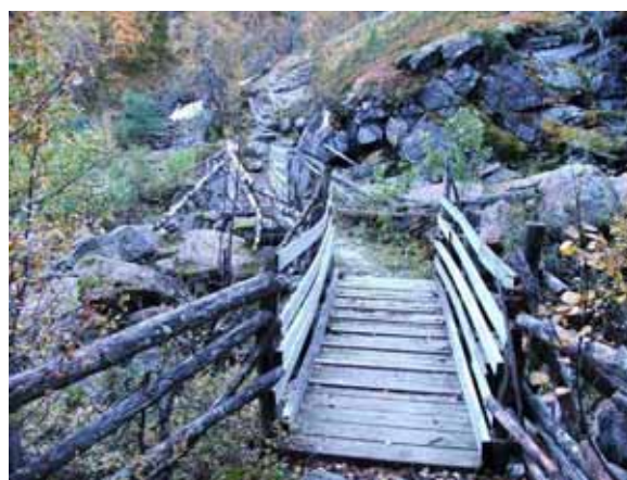
Figur 7.55. Gangbru over Liadøla.
