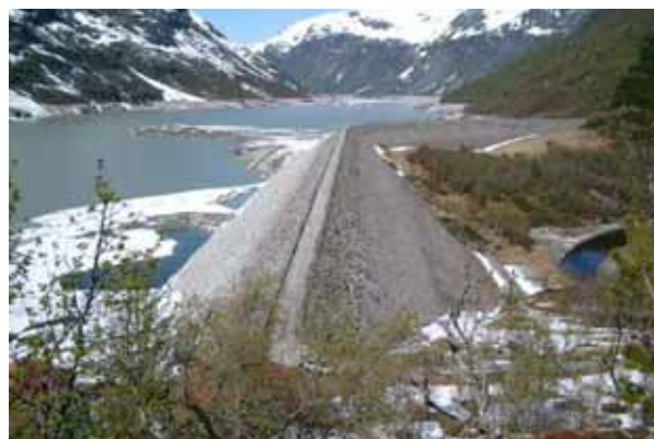
Figur 4.6. Oversikt over dammen med utløp av flomkanal til høyre.
