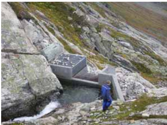
Figur 4.5. Vivaskredene bekkeinntak. De planlagte bekkeinntakene blir av lignende type som dette.
