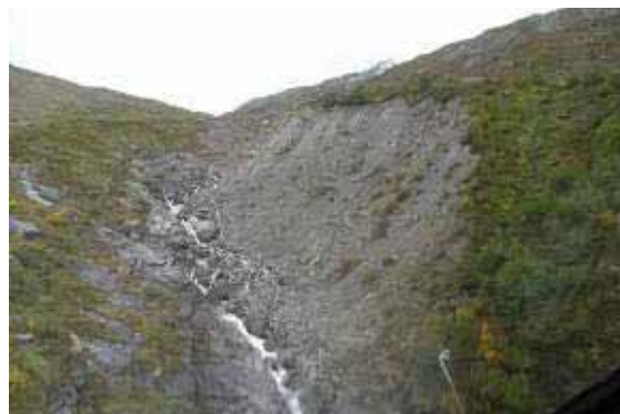
Figur 7.5. Undergraving av skråning i Røykjedøla.
