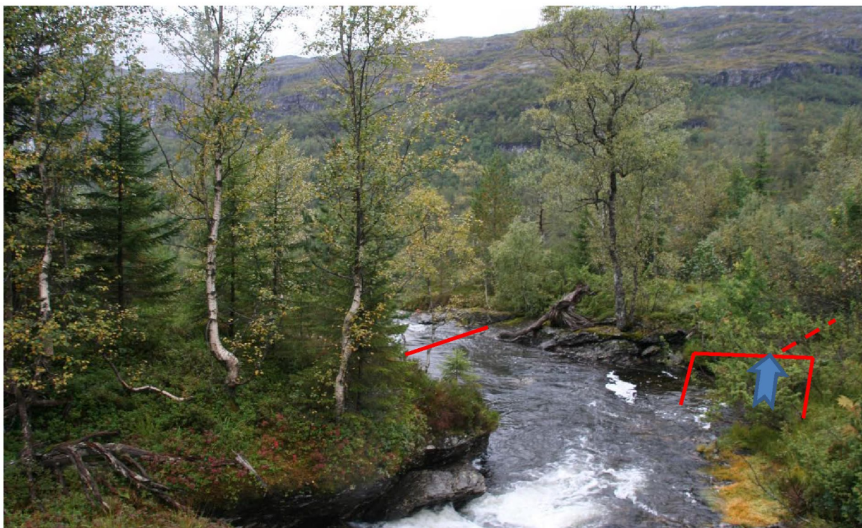
Figur 5 - 12: Bilete av inntaksområde i Hedlerelvi som over. Raud line indikerer planlagt terskel og blå pil indikerer plassering av utlaup / inntakskammer i ein naturleg «kulp» i sidekanten på elva. Foto; Yngve Tranøy
