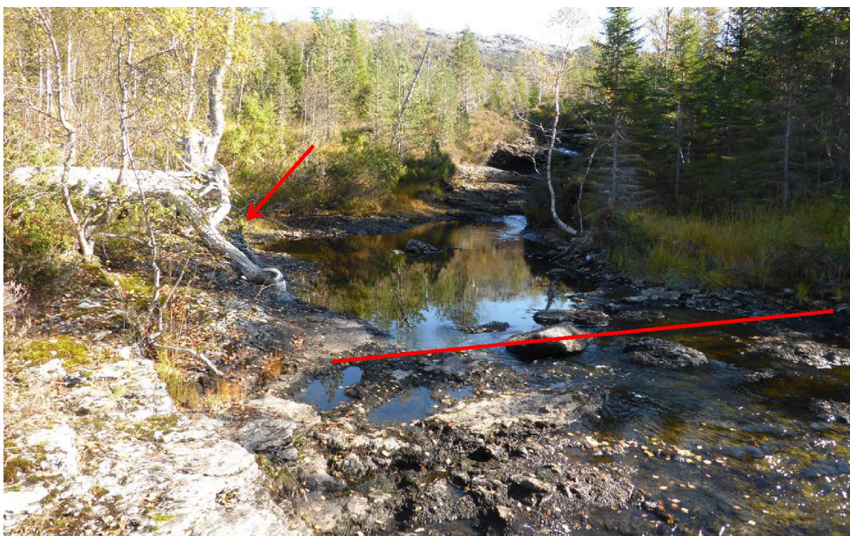
Figur 5 - 13: Bilete av sideinntaket sett mot nordaust. Inntakskammeret er indikert med raud pil. Terskel med overlaup markert med raud strek. Inntaket vil ikkje vera synleg frå særleg avstand. Foto; Ole Reidar Flatby
