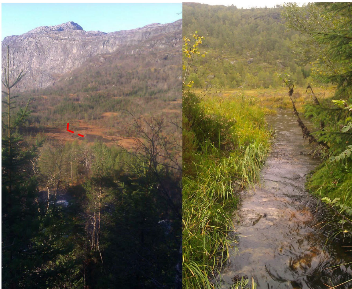
Figur 5 - 7: Til venstre; Oversiktsbilete av Lomtjørni teke mot vest frå planlagt tomt for sideinntak i Hedlarelvi. Trase for naturleg avrenninga frå Lomtjørni til Stølselvi er indikert med raud line. Nærbilete teke mot nord av naturleg terskel i utlaupet frå Lomtjørni mot Stølselvi til høgre. Bekken frå Lomtjørni til Stølselvi må reinskast opp og forsterkast litt i kantane dersom ein får konsesjon til overføringa. Foto; Yngve Tranøy
