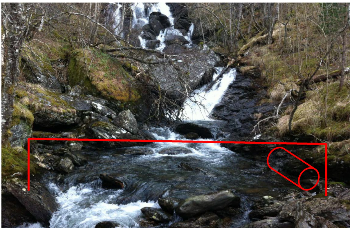
Figur 5 - 14: Område for hovudinntaket i stølselvi ved kote 148. Planlagt sperredam på fast fjell som indikert med raud line. Foto; Ole Reidar Flatby
