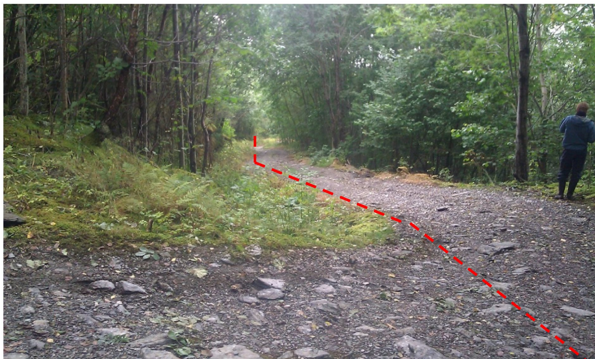
Figur 5 - 16: Bilete av skogsveg like nedstraums hovudinntak. Trykkrøyet vil leggjast langs stølsvegen ned til planlagt kraftstasjon. Foto; Ole Reidar Flatby.
