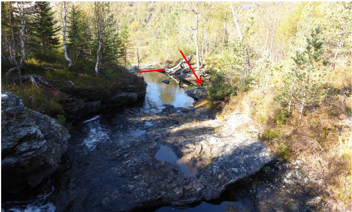
Figur 5 - 11: Bilete teke mot vest ved planlagt inntak for overføring i Hedlerelvi ved kote 430. Raud line indikerer planlagt terskel i elva. Raud pil indikerer plassering av utlauf mot overføringsrøyr. Foto; Ole Reidar Flatby
