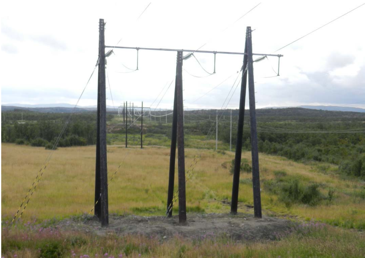
Figur 1. FMV (forankringsmast) – rundtømmermast
