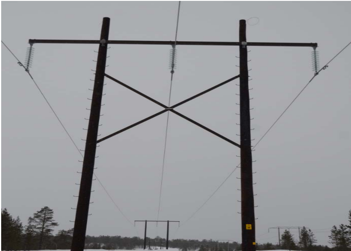
Figur 3. BM (Bæremast)- Rundtømmermast
