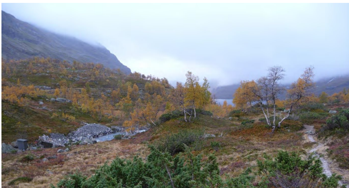
Tidligere tiltak i Middalselva til venstre i bildet, like nedstrøms broen over elven. Sti/stølsvei til Middalsbu går langs nordsiden av Middalselva. Bilveien ser en i terrenget midt i bildet.
