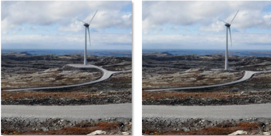
Figur 23: Minst mulig eksponering av kranoppstillingsplass og fundament er viktig for god landskapstilpasning, her vist ved senking av oppstillingsplass slik at utstrakte fyllinger unngås og gjenstående knauser delvis skjerner for innsyn.
