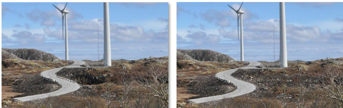
Figur 12. I det fotomanipulerte eksempelet er det fylt igjen masser i et dalsøkk foran fremre turbin. Inngrepene samles samtidig som vegen gis en bedre forankring i landskapet ved å unngå fyllingsskråning på begge sider av vegen og kranoppstillingsplass for turbinen blir mindre ruvende.
