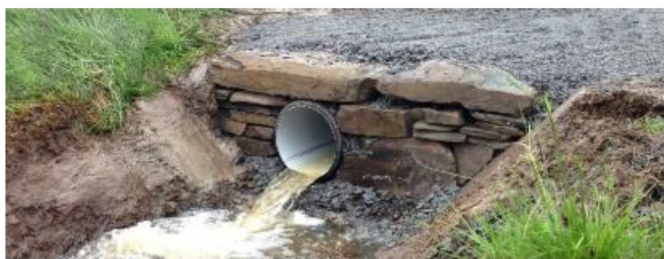
Figur 19. Bildet viser en god bearbeiding inn mot utløpet av stikkrenna. Grad av opparbeiding må tilpasses sted og eksponering.
