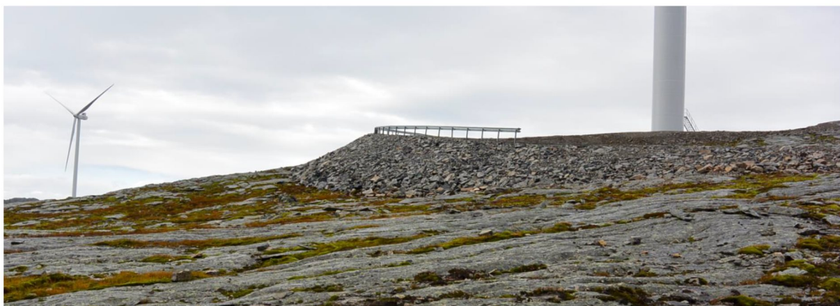
Figur 10 Bildet viser hvordan en relativt ryddig, godt pakket steinfylling fremstår som en veltilpasset konstruksjon i et område med mye fjell i dagen.
