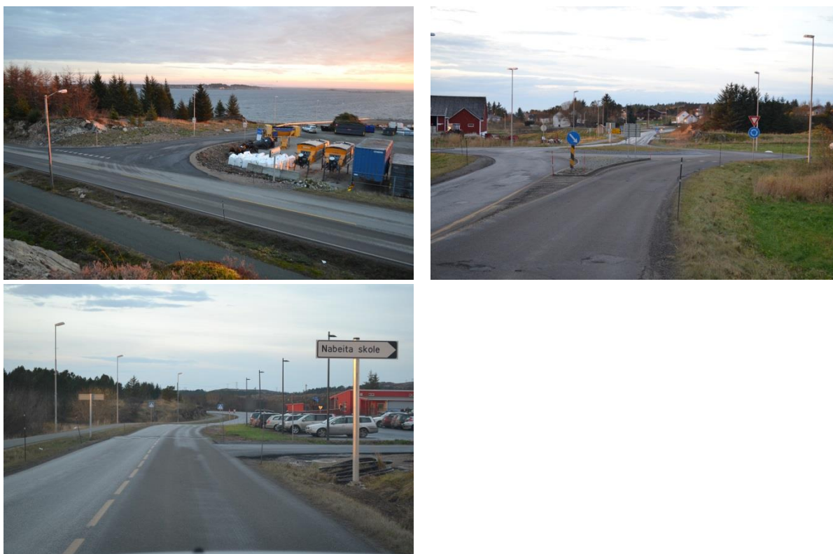
Figur 5: Krysset fra Nordhammervika kai, rundkjøringa ved tunnelen, fartsdumper ved Nabeita skole.
