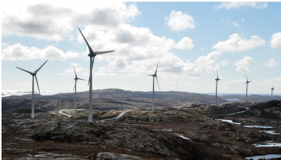
Figur 15. I det småkuperte landskapet er økt veglengde å foretrekke foran skjæringer. Bildet viser hvordan et godt tilpasset vegnett slynger seg med terrenget.
