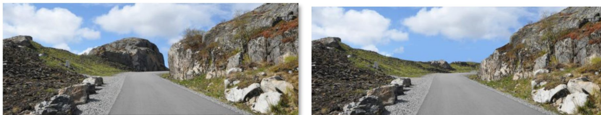
Figur 21: Ved behov for ekstra masser tas positive former ut i sin helhet. I det manipulererte bildet til høyre, er en større gjenstående knaus fjernet og benyttet som massetilskudd, samtidig som man har tatt toppen av skjæringa på motsatt side. Mindre knauser har fått stå igjen for variasjon og en mer naturlig flate.
