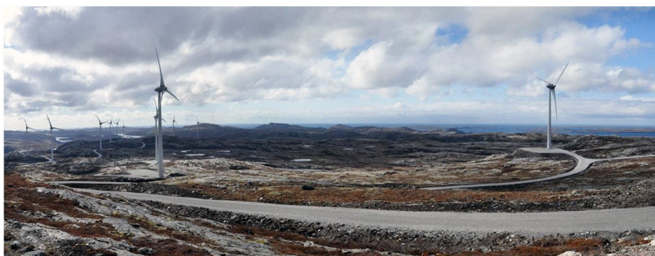
Figur 22: Panoramabildet viser kranoppstillingsplasser som generelt ligger godt i terrenget, med unntak av den ved vindturbinen til høyre i bildet som ligger noe høyt og blir dertil eksponert.
