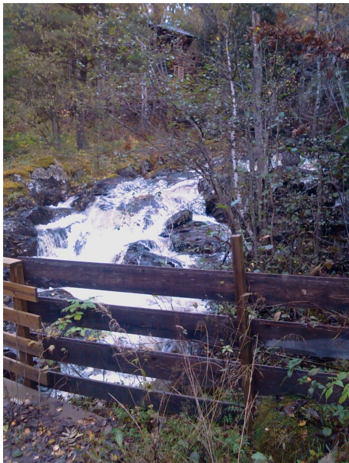
Bru over Føssa ca. kote 225
