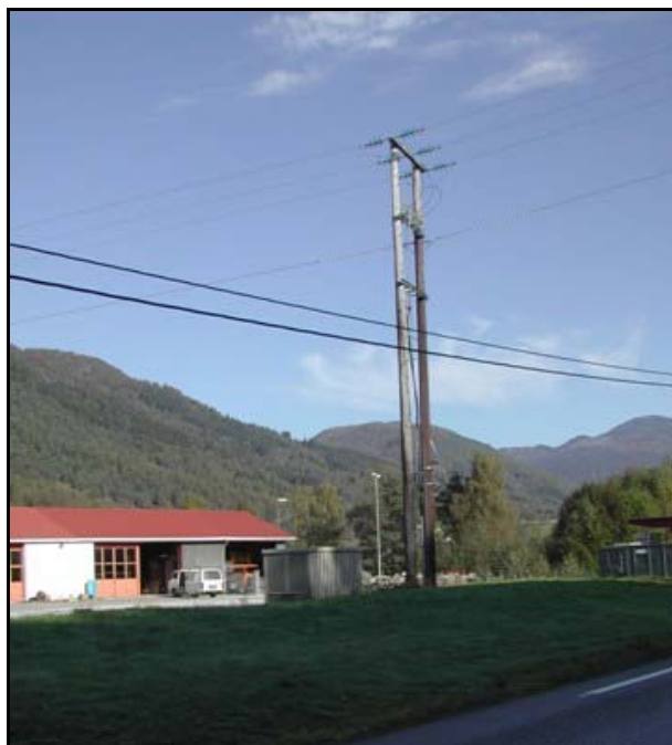
Biletet viser aktuelt nett-tilkoplingspunkt nær Sande sentrum.
