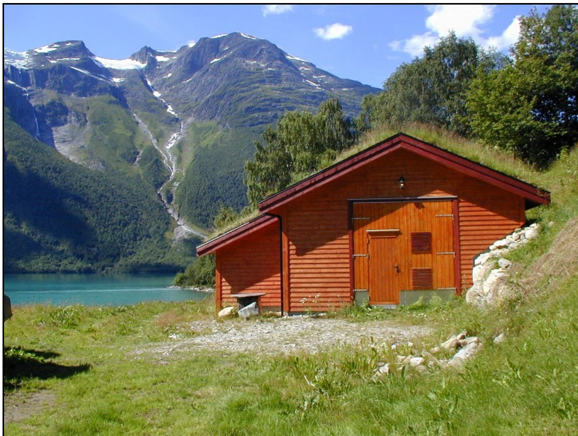
Biletet er eit eksempel på tilsvarende kraftstasjonsbygning og viser Vasstaket kraftstasjon i Loen.
