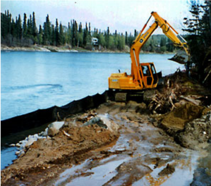
Figur 3: Langsgående siltgjerde for erosjonssikring helt ned mot en elv. Siltgjerder kan brukes langs elven for å hindre sedimentasjon i elva i forbindelse med graving helt ned til elvebredden. Gjerdet graves ned i elvebunnen og forankres godt med jord, stein og sikkerhetspåler. (Kilde: http://www.sf.adfg.state.ak.us/SARR/restoration/techniques/silt.cfm )
