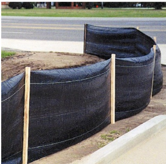
Figur 10: Et korrekt installert siltgjerde kan fange opp store mengde sedimenter. Dette gjerdet skulle vært tømt for lenge siden, men illustrere
