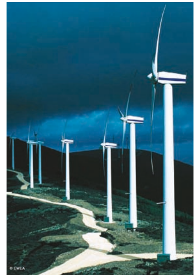
Figur 7.23 Skyggekast fra vindturbin. Foto: Wind energy conference & exhibition.
