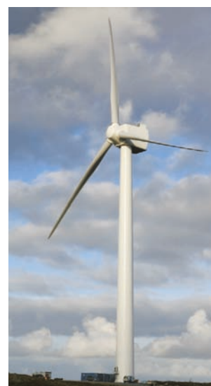
Figur 7.2 ScandWind turbin (3 MW) uten gir. Foto: Jostein Vårild Lyse.
