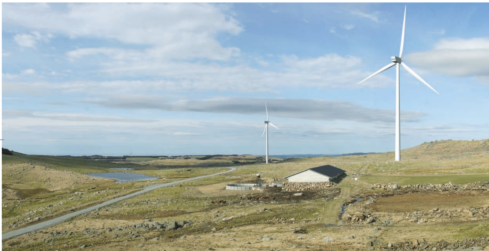
Figur 5.1 Vindturbiner, Brusali-Karten vindpark. Montasje: Inter Pares AS.
