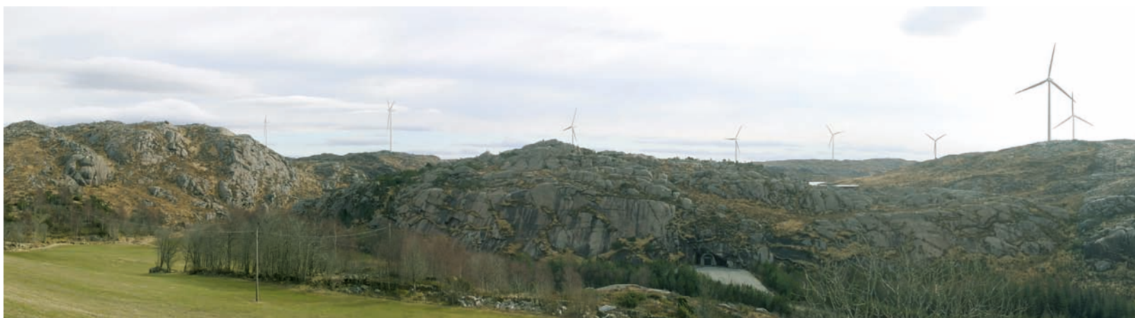
Figur 7.16 Brusali-Karten vindpark sett fra Eikeland. Det er snaut 800 meter til nærmeste turbin, til høyre i bildet. Montasje: Inter Pares AS.
