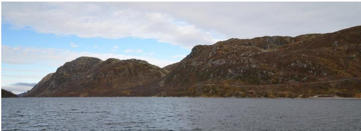
Bitdalsvatn, nordøstlig del. Kraftledning og bratt terreng på nordsiden av magasinet. Foto: Kjetil Flydal.
