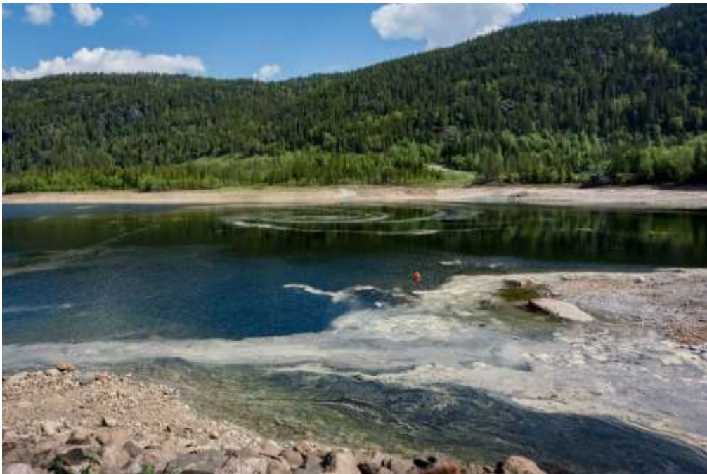
Bildet viser strømhvirvel som danner seg over bunn inntak til driftstunell Lio kraftstasjon i Byrtevatn. Kontinuerlige vannstandsendringer i reguleringsmagasin resulterer i errodering og utvasking av finsediment fra magasinstrand. Sedimentholdig vann føres ut i Tokkeåis nedre del gjennom Lio kraftstasjon.
