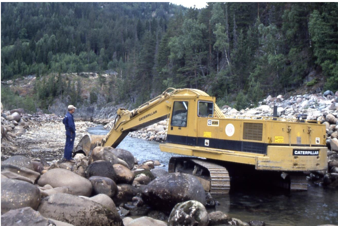
Regulanten gjer utretting og senking av elveløp nedanfor Åmøte-Bruhylen i 1986 med 70 tonns gravemaskin.
