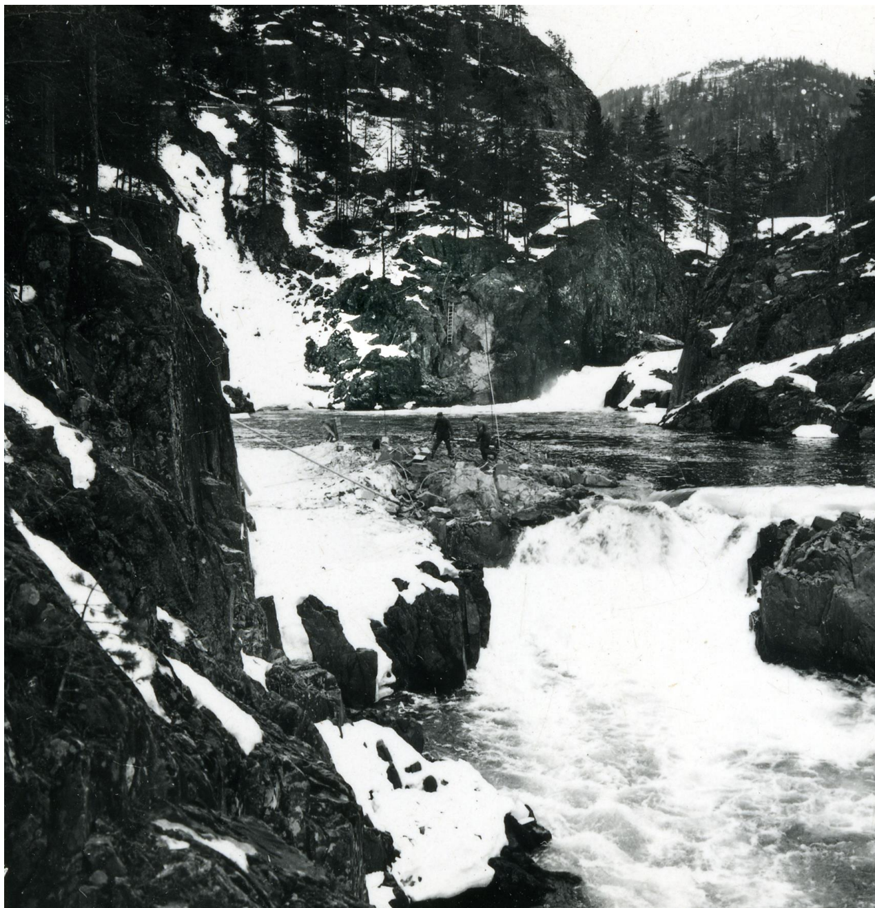
Figur 7. Fotografi fra anleggsperioden for byggingen av Lio kraftverk. På dette bildet er nedstrøms elvestrekning mot Åmøtehylen senket, noe som medførte økt fossefall i det nederste fossetrinnet. Det ble i sin helhet sprengt bort, og disse tiltakene definerer dagens senkede vannspeil i Helveteshylen.
