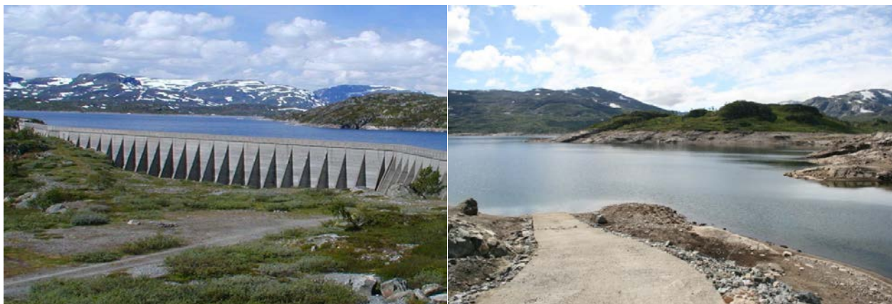
Figur 10.4 Kjelavatn dam (til venstre). Til høyre Kjelavatn ved båtutsett. Bildet er tatt 3.8.10, vannstand kote 930,83. Fyllingsgrad i magasinet var 34 %.
