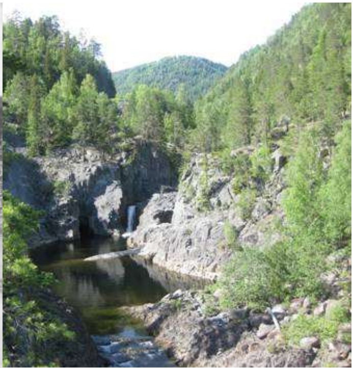
Helvetesfossen og utløp Lio kraftstasjon i dag
