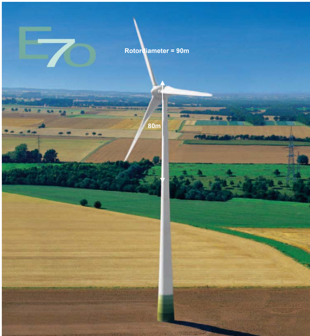
Figur 4.3. ENERCON E 70 2,3 MW (fra ENERCON brosjyre)
