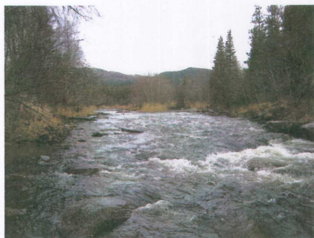
Bilde oppstrøms inntaksdam, tatt samme sted som bildet til venstre
