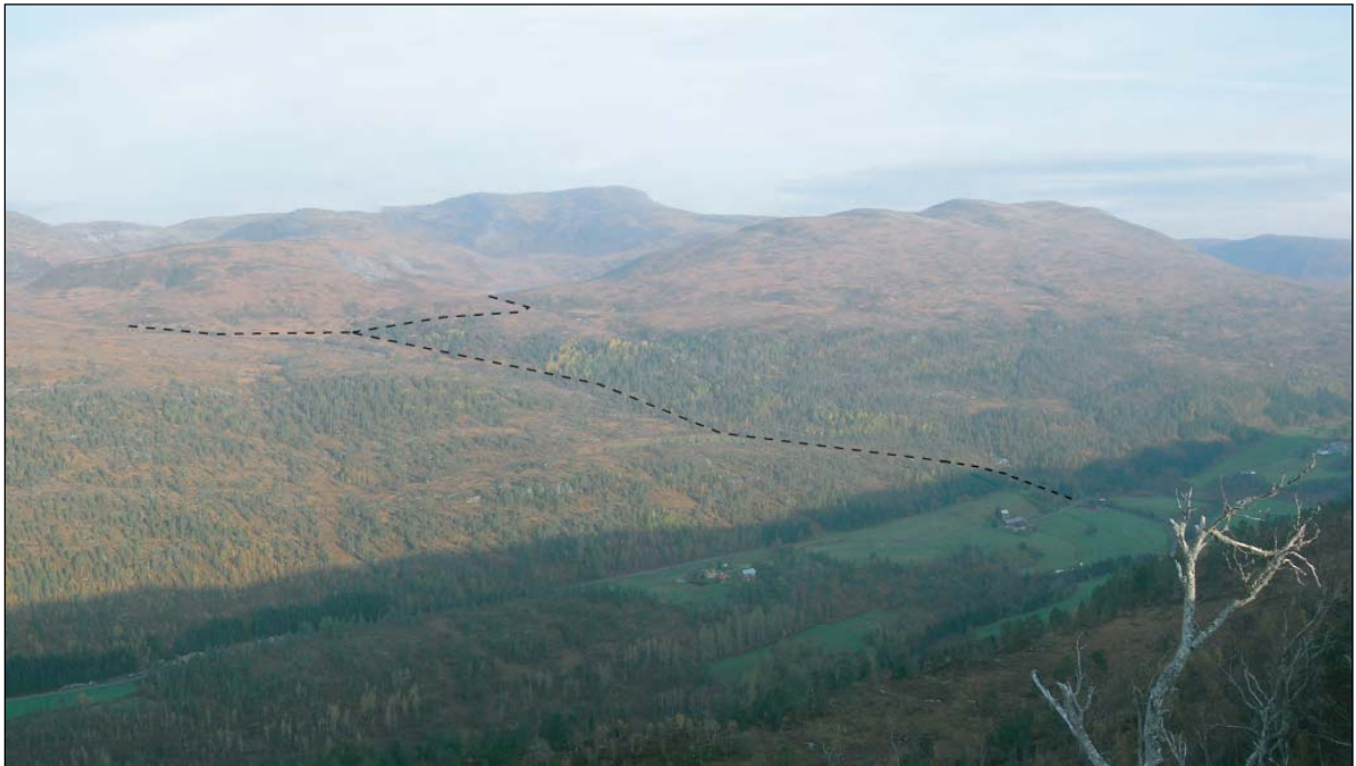
Bilde 1. Oversiktsbilde som viser rørgatens plassering i terrenget.
