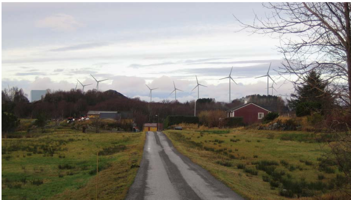
Vindturbinar (2 MW) og planlagt industrianlegg sett frå Korsund.
