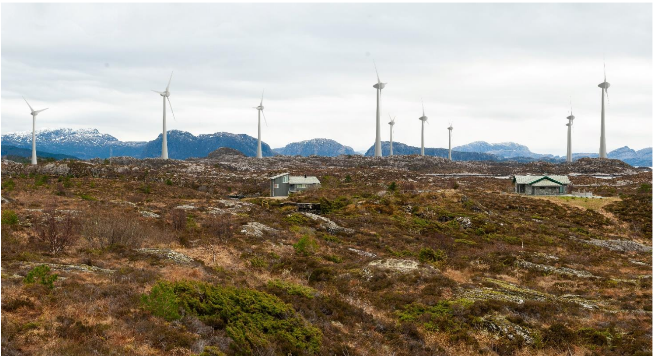
Figur 12: Lammetun kystfort. Fotomontasje av konsesjonssøkt layout med 10 Enercon E-126 turbiner.
