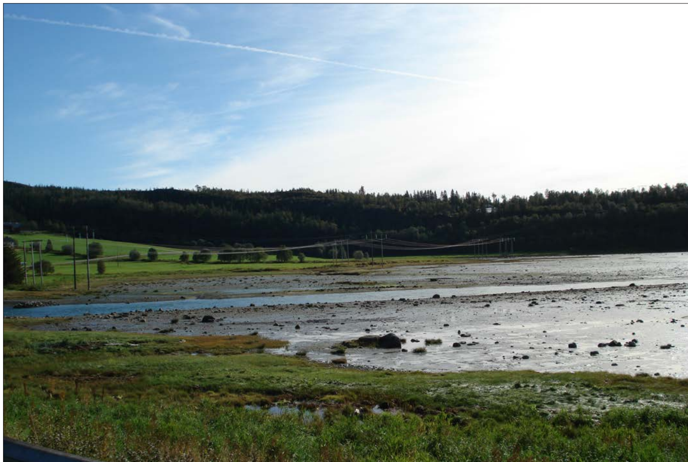
Foto 8: Alternativ 1. Dagens situasjon ved Mæla.
