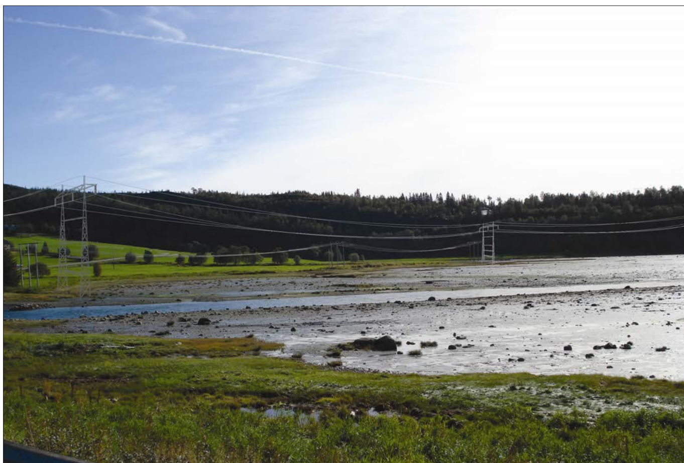
Illustrasjon 14: Alternativ 1. Ny nettlinjetrasé ved Mæla er illustrert med høyde 20 m. Foto viser dagens parallelle linjer og ny oppgradert linje. Mastestørrelser og avstanden mellom mastene vil kunne avvike fra visualiseringen, ettersom mastetypen ikke er bestemt ennå. Synligheten vil være avhengig av lysforholdene. (ill: Agraff)
