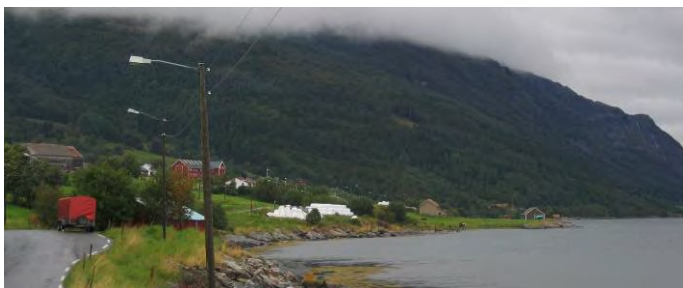
Strand med Kjellersjåbygningen i midten
