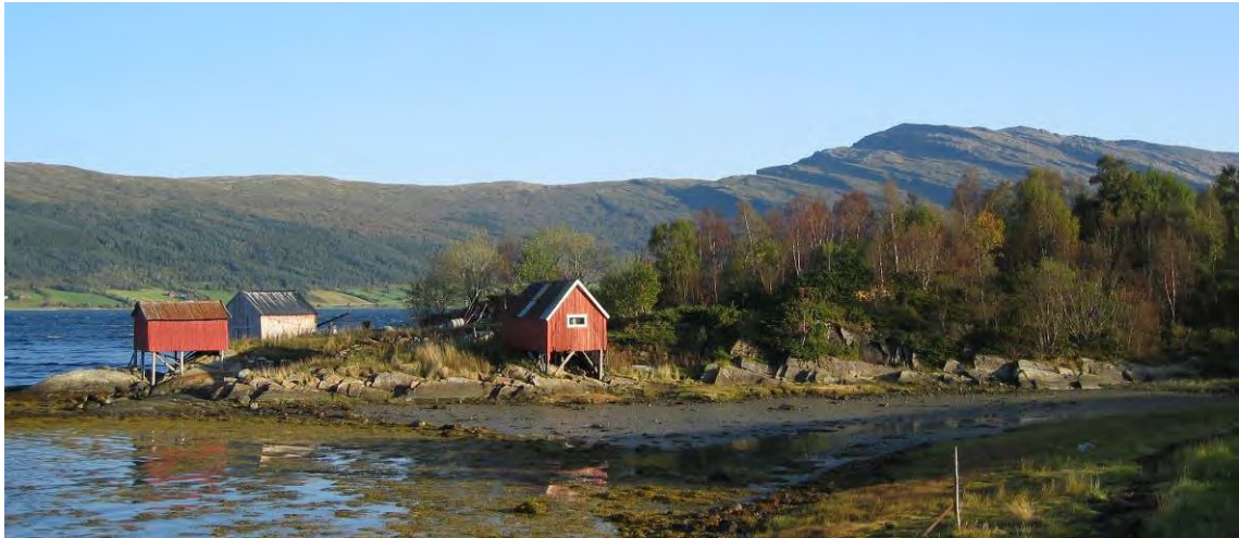
Naustmiljø ved Låvong (ikke Sefrak registrert, Sjonfjellet til høyre)
