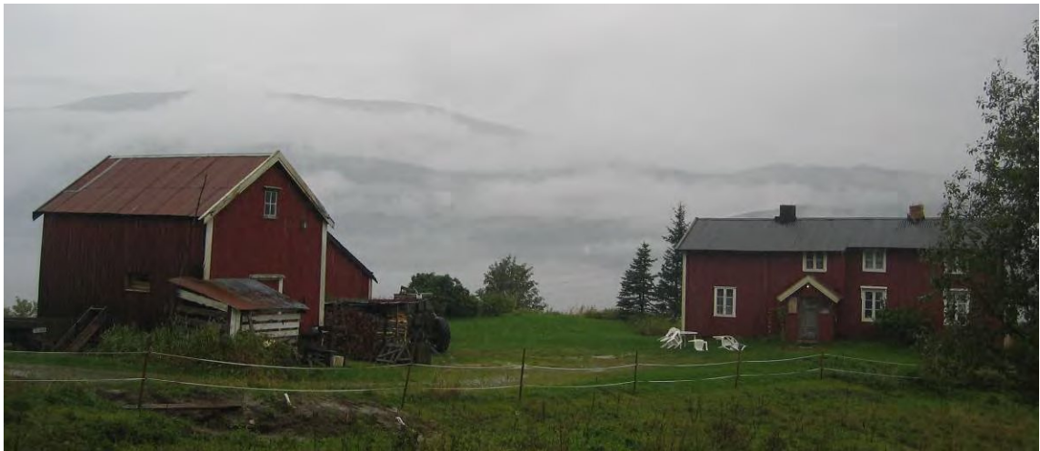
Gårdstun på Brattland (168/3) som henvender seg mot Sjonfjellet delvis synlig i tåka
