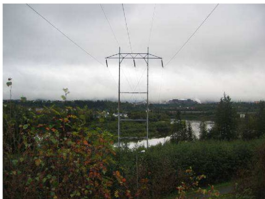
Eksisterende kraftledning mellom Mjølan og Mo industripark
