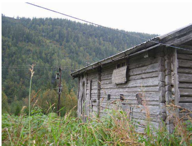
Laftet høyløe (eksisterende kraftledning i lia i bakgrunnen)
