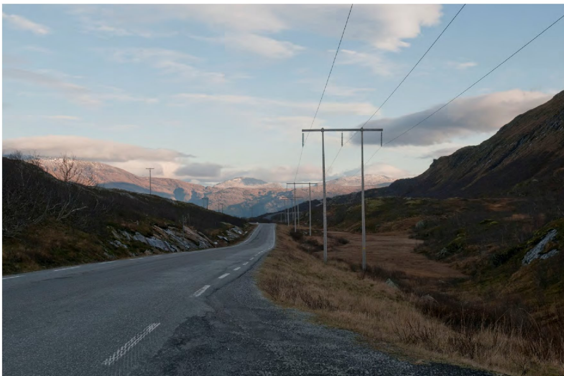
Figur 34: RV 17 med parallell kraftledning vitner om den menneskelige påvirkningen i delområdet.
