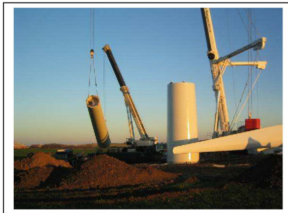
Figur 18: Typisk riggplass-situasjon, 2 MW
