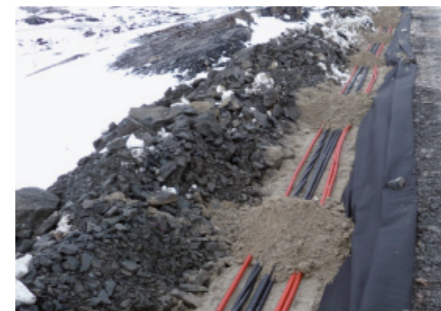
Fig. 6.4: Kabel- og fibertrase i veiskulder i vindpark før gjenlegging (Ill. Nygårdsfjellet vindpark, Narvik kommune)
