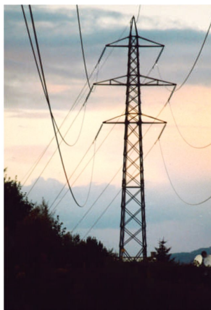
Figur 6-12 2-kurs master av varmforsinka stål. Største bredde er 8 meter. Denne vil vere 7,5 meter høgre enn limtremasta. Betongfundament. Naudsynt breidd på rettighetsbelte er 28 meter.
