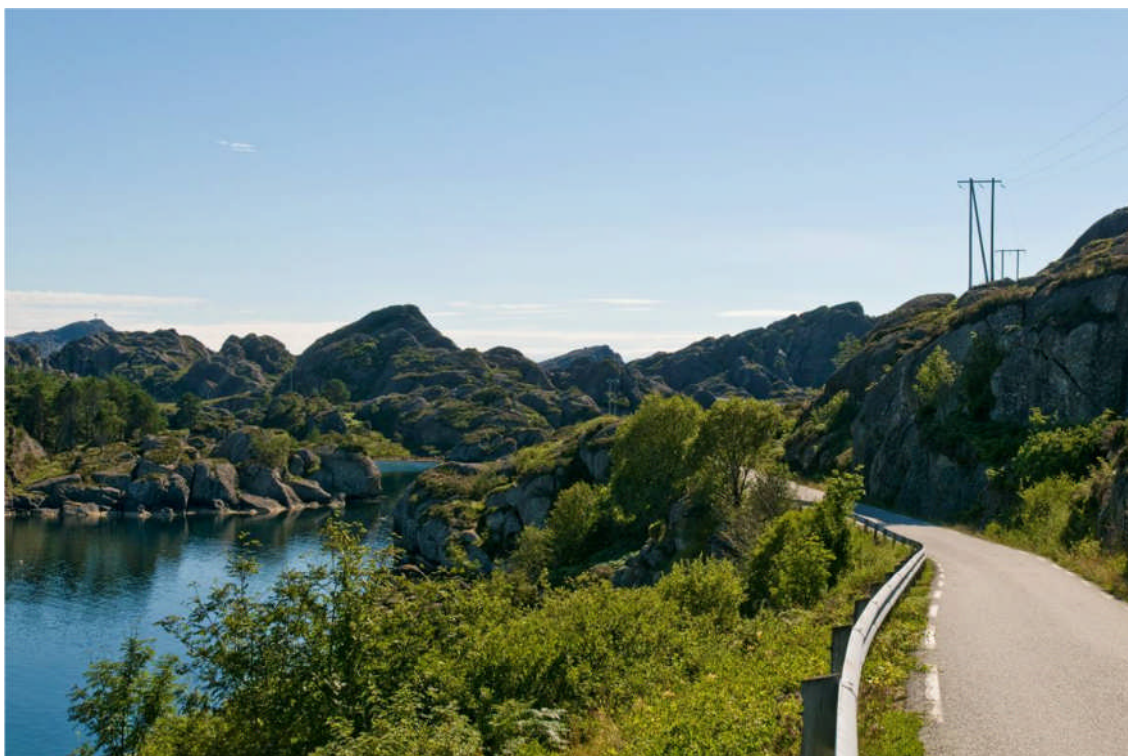
Figur 9-1. Eksisterende lokalnett på Ytre Sula kan på deler av strekningene saneres/kables.
