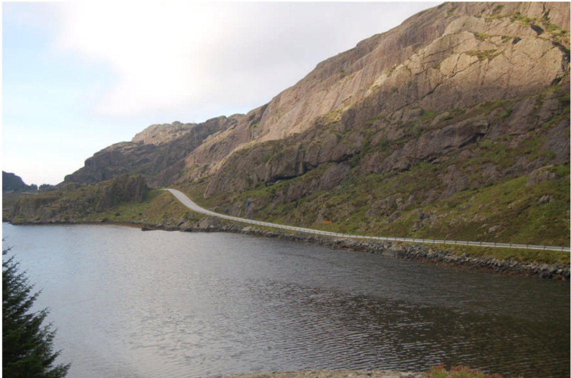
Figur 4-23 Parti av vegen mellom Krakhella-Hardbakke
