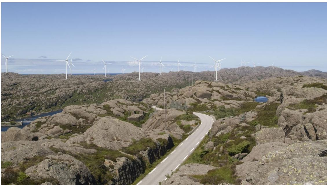
Figur 21: Utsyn mot en stor del av vindkraftanlegget sett fra en kulle ved "Grendelagsbenken" nord for Trovåg. Bare små avsnitt av både eksisterende vei og internveier i vindkraftverket er synlige. Visualisering: Turid Stærnes, Ask Rådgivning.
