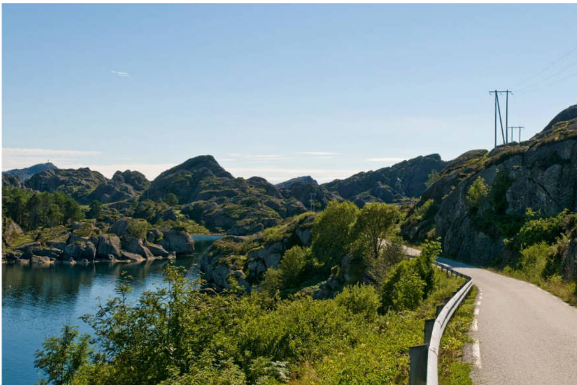
Figur 21. Eksisterende lokalnett på Ytre Sula kan på deler av strekningene saneres/kables.
