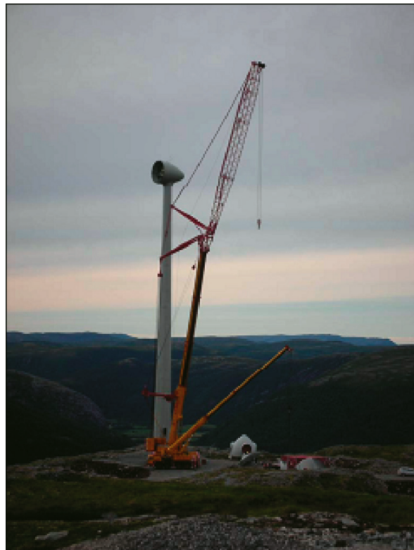
Figur 5. Montasje av vindturbin.
