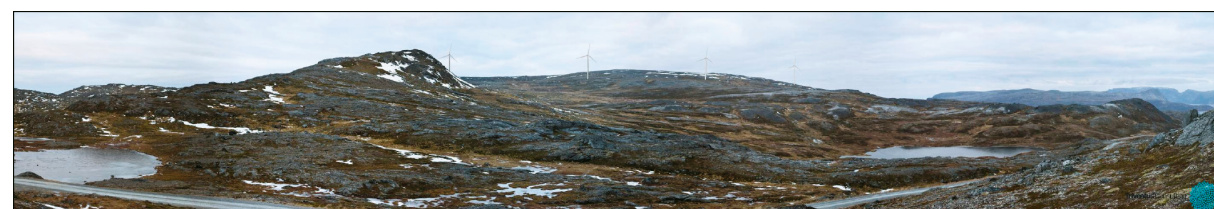
Figur 10. Fotomontasje Brennhaugen, 4 turbiner sett fra punkt like ved Dønnesfjordveien.
