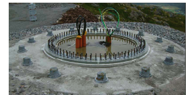
Figur 9. Fundament for 2,3 MW vindturbiner.
