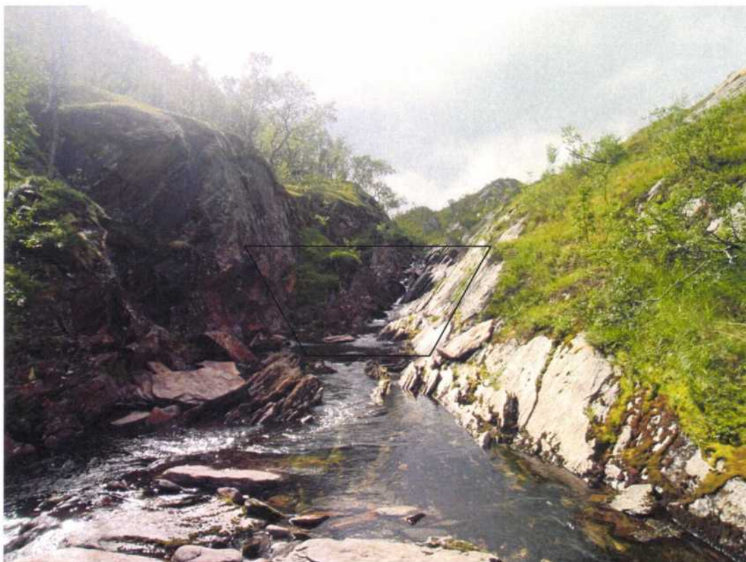
Bilde 2.1. Bildet viser området for ny inntaksdam, ca. 65 meter nedstrøms for den opprinnelig planlagte.
