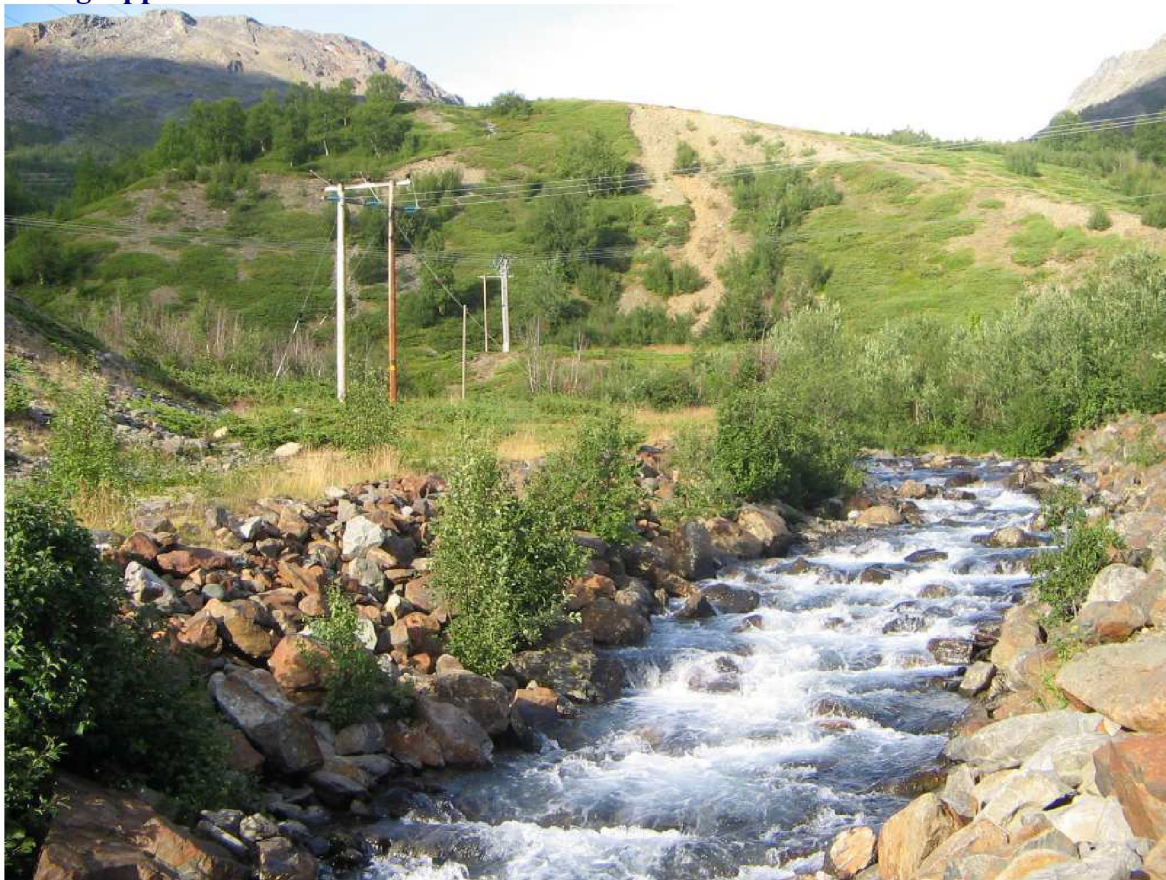
Bilde 2.1 Elva nedenfor stasjonen
