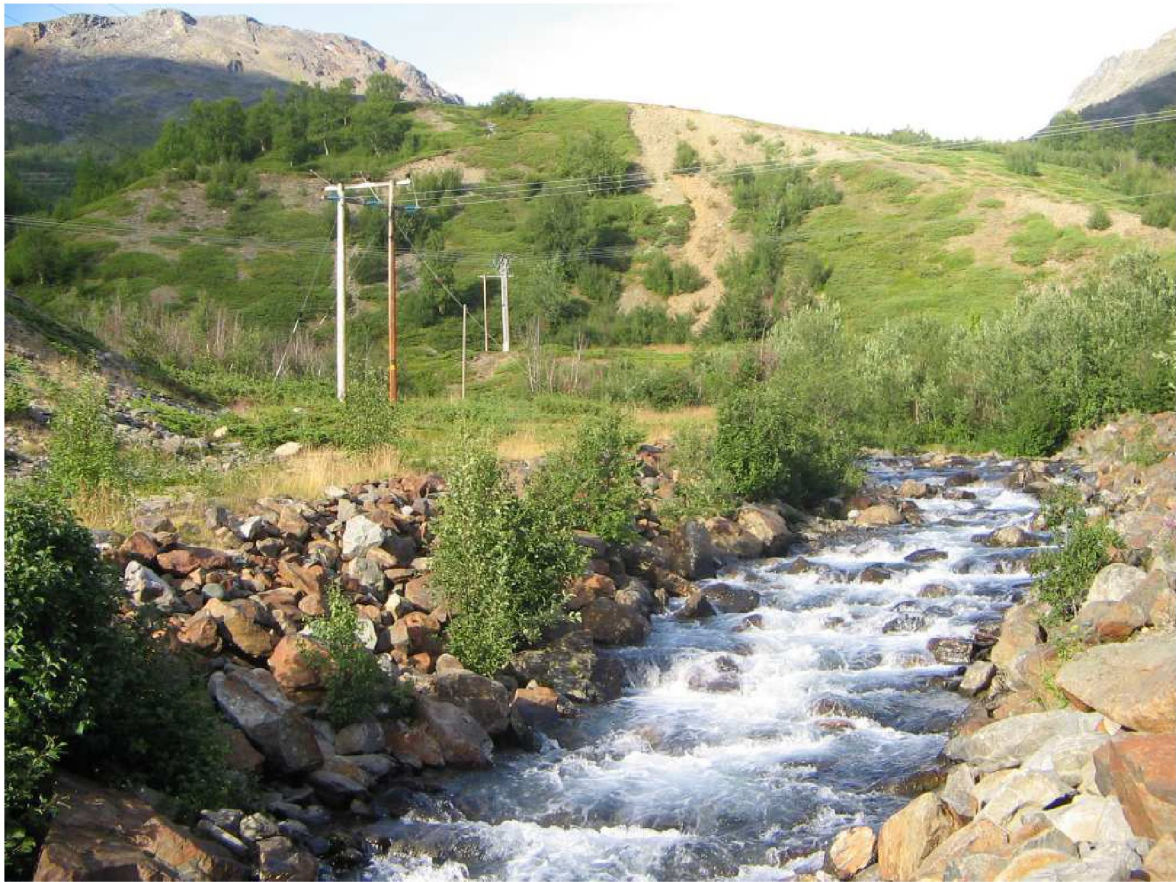
Bilde 5.1 Eksisterende 22 kV nett
