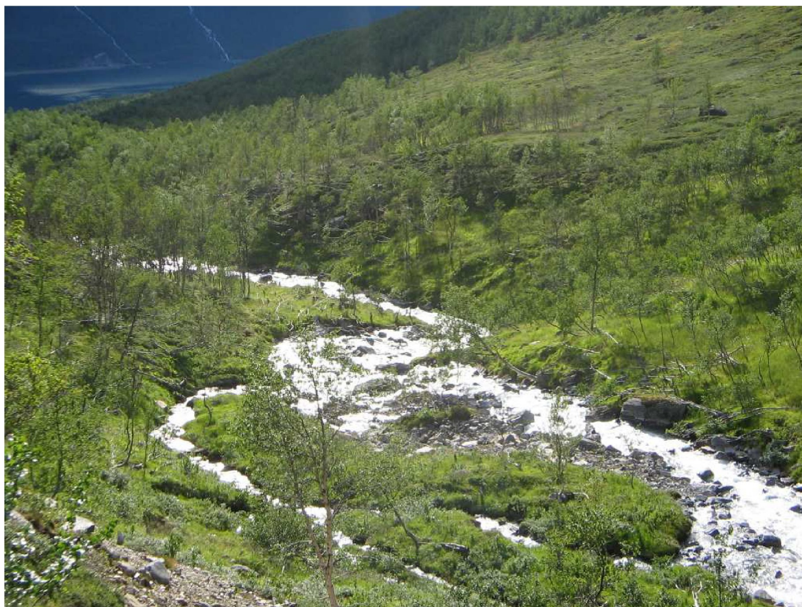
Bilde 1.1 Inntak iog demning sett ovenfra ca kote 420 moh
