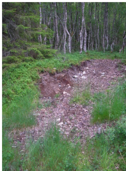
Figur 5: Traktorveg ved adkomsten fra sør
