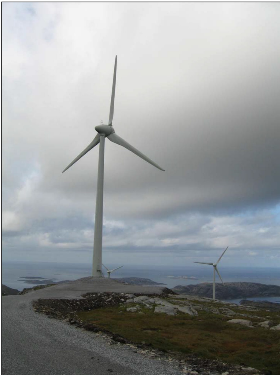
Figur 7: Turbin med internveg og kranoppstillingsplass.
