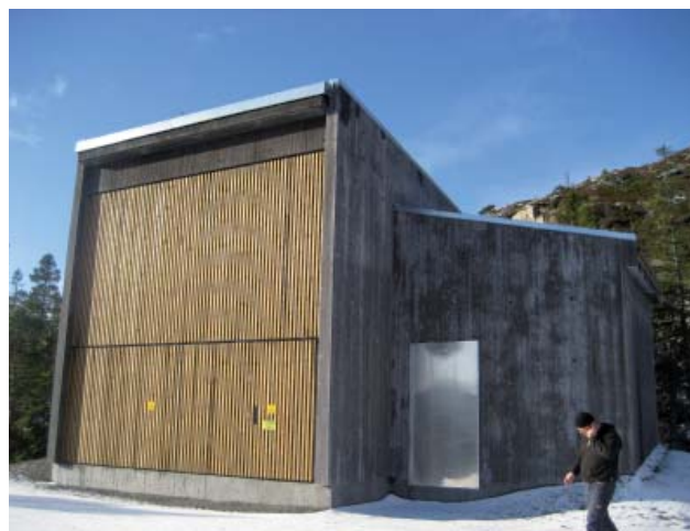
Figur 9: Eksempel på trafostasjon fra vindkraftverk på Bessakerfjellet
